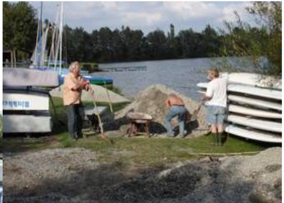
eingemessen, dementsprechend wurde diese mit Kies korrigiert. Dank geliehenem Rüttler der Fa. Schwall erfolgte die optimale Verfestigung des Untergrundes.
